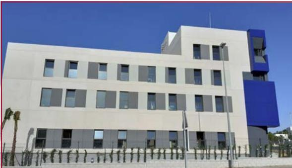
La envolvente del edificio está realizada mediante estructura de hormigón armado y fachada prefabricada con paneles de hormigón arquitectónico en dos colores, esto ha permitido optimizar en el plazo de ejecución de la obra.
