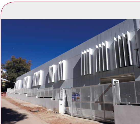
Hospital Oncológico, Málaga
